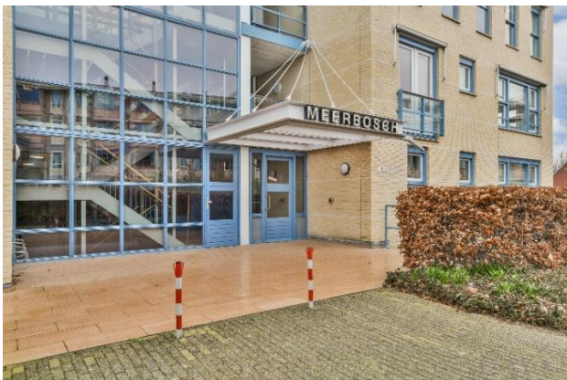
De afgesloten hoofdentree bevindt zich aan de zuidoostzijde van het complex
